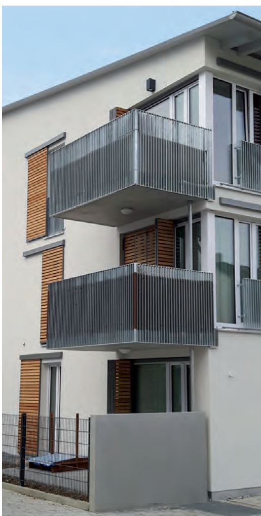
Bauvorhaben in der Lohfeldstraße 6 a in Krailling (Bild links); Gartenansicht (Bild unten).
