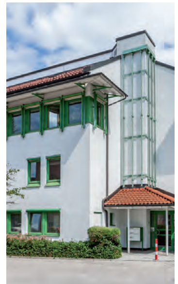
Verwaltungsgebäude in der Gradstraße 2 a, Starnberg.
